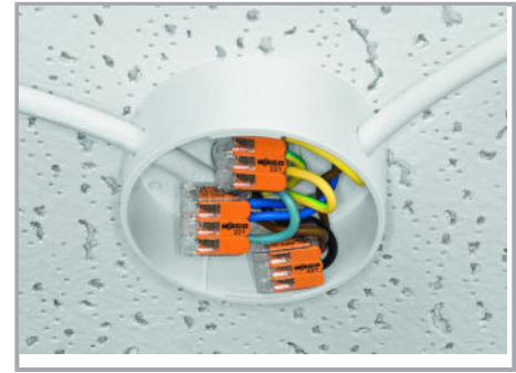
Leuchtenverteilung in Deckenbaldachin
